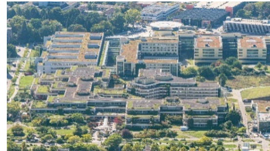
Universitätsklinikum Heidelberg (Bild UKHD) Sanierung Kopfklinik
